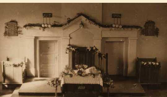
Původní interiér kaple.
