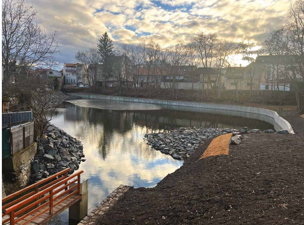
Hrubý lomový kámen na okrajích rybníku v dohledné době doplní dřevěné molo, připravené ke slunění a zřejmě i jako nástupní plocha ke koupání.
