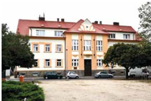
Legionářský dům byl letos zásadně zrenovován (oprava střechy včetně výměny krytiny, nová okna, nová fasáda, výměna okapů, nové hromosvody a různé jiné opravy). Další opravy byly provedeny již v roce předešlém.
