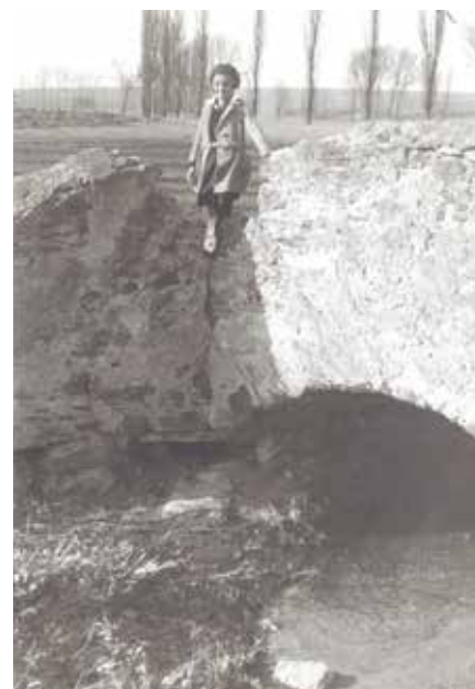
Takhle to vypadalo u propustku Říčanky v místě, kde opouští oboru a podtéká pod komunikací z Netluk do Dubče cca v roce 1935. Na fotce je maminka autora textu. (Propustek v současné době prochází rekonstrukcí z důvodu větší propustnosti toku.)
