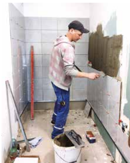
Misuri prochází rekonstrukcí.
