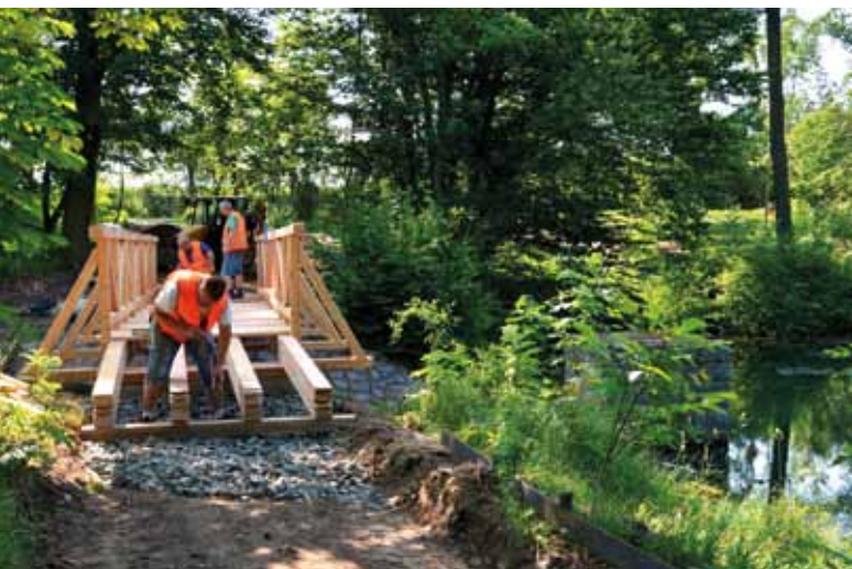
Instalace mostku je náročná na přesnost uložení.
