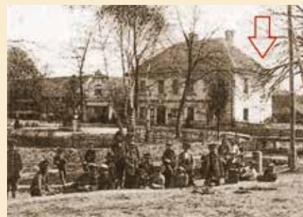
↑ V kůlně na dvoře bývalé radnice (dnes nám. Bratří Jandusů 33/32) byla v roce 1923 dočasně zřízena malá elektrárna, která umožnila osvětlení některých ulic, dílen, obchodů, domácností a školy (přibližná poloha dočasné elektrárny je označena šipkou, foto: Archiv Uhřetěveského muzea)
