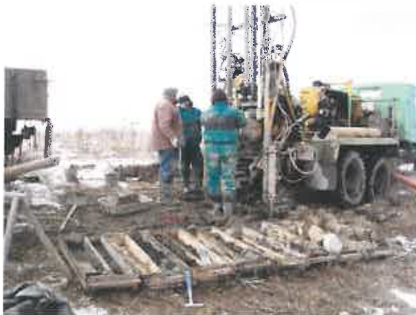
Obrázek 2: Vrtání, jádro uložené ve vzorkovnicích
